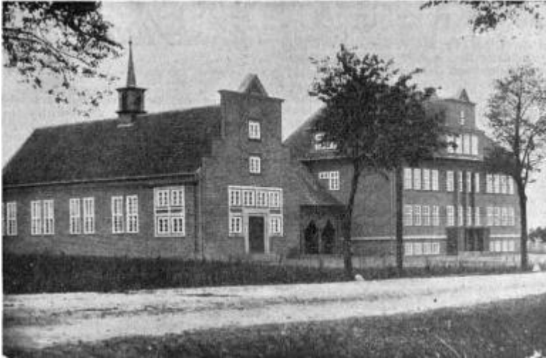
Die Schule in Kreuzburg Alle Klassenzimmer sollten hell sein. Diese Forderung wurde durch die Anordnung hoher Fensterreihen in den stattlichen Gebäuden erfüllt.
