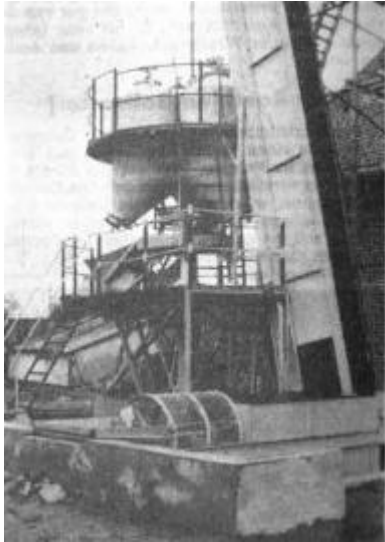
Viele der Grünfütter-Trocknungsanlagen im nordwestdeutschen Raum sind kombiniert mit einer Kartoffel-Großdämpfanlage (Friedeburg/Ostfriesland) Foto: Dr. Schwarz
